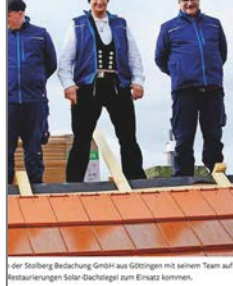
der Stöberg Bedachung GmbH aus Göttingen mit seinem Team zur Restaurierung Solar-Dachziegel zum Einsatz kommen.
