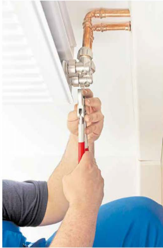
Anlagenmechaniker für Sanitär-, Heizungs- und Klimatechnik bei der Montage eines Heizkörpers. Foto: AHM Online
